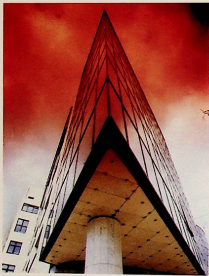
POSLOVNA ZGRADA CROATIA D.D.
